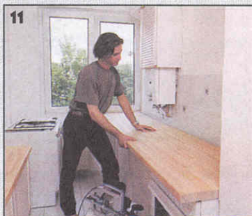
11 Прежде чем установить рабочую плиту, ее тщательно подгоняют. Готовую плиту потом привинчивают снизу шурупами.
