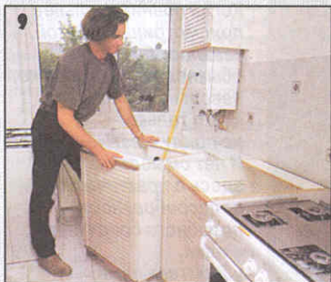
9 Готовые предметы мебели устанавливают в ряд ...
